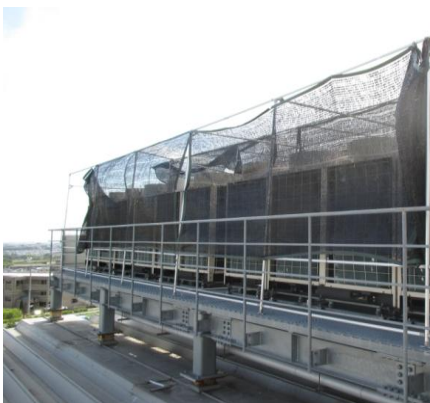
エアコン室外機 遮光ネット設置
