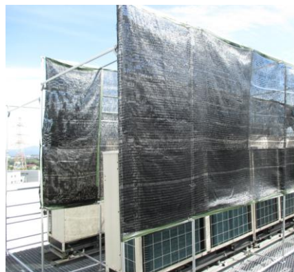
エアコン室外機 遮光ネット設置
